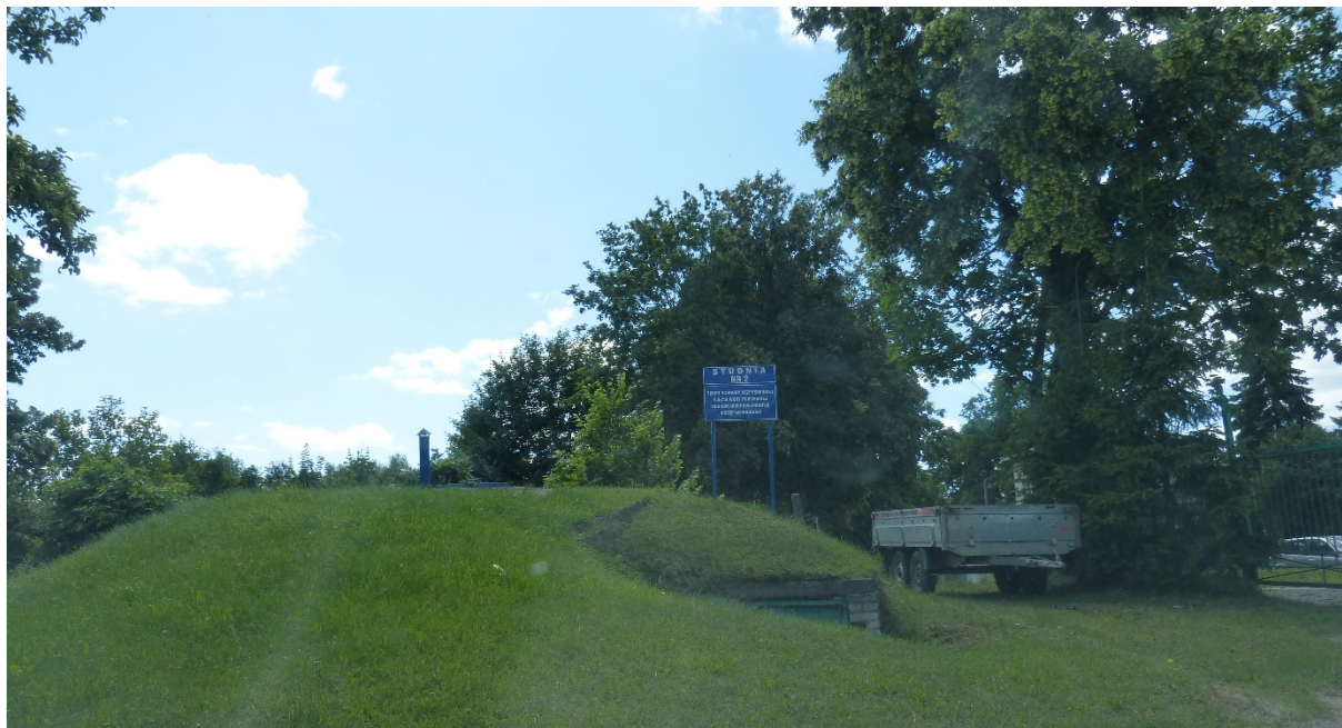
Fot. 6 Zlikwidowane urządzenie wodne – studnia nr 2 na terenie miejskiego ujęcia wody podziemnej Decyzją Nr BI.ZUZ.1.4210.3.11.2021.KMP, Dyrektora Zarządu Zlewni w Augustowie
